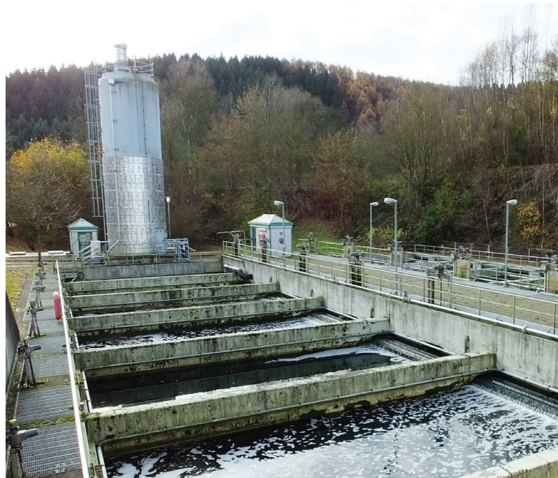
Einsatz von Aktivkohle auf der Kläranlage Buchenhofen
