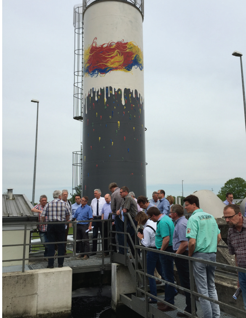
Besichtigung der PAK-Anlage auf der Kläranlage Dülmen.
