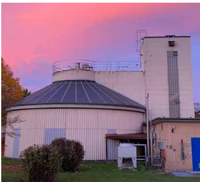
Faulturm Kläranlage Melsungen
