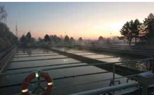
Kläranlage Erdinger Moos
